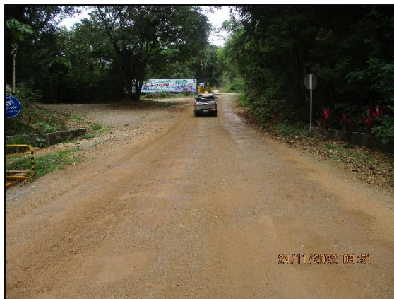
ภาพที่ 2.13 สภาพเส้นทางการลำเลียงแร่ที่ ปรับแต่งผิวถนนและบดอัดแน่น
