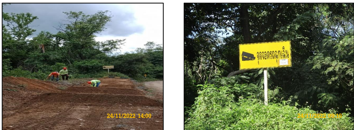
ภาพที่ 2.37 ไหล่ทางบริเวณเส้นทางขนส่งแร่ เพื่อใช้จอดรถในกรณีฉุกเฉิน
